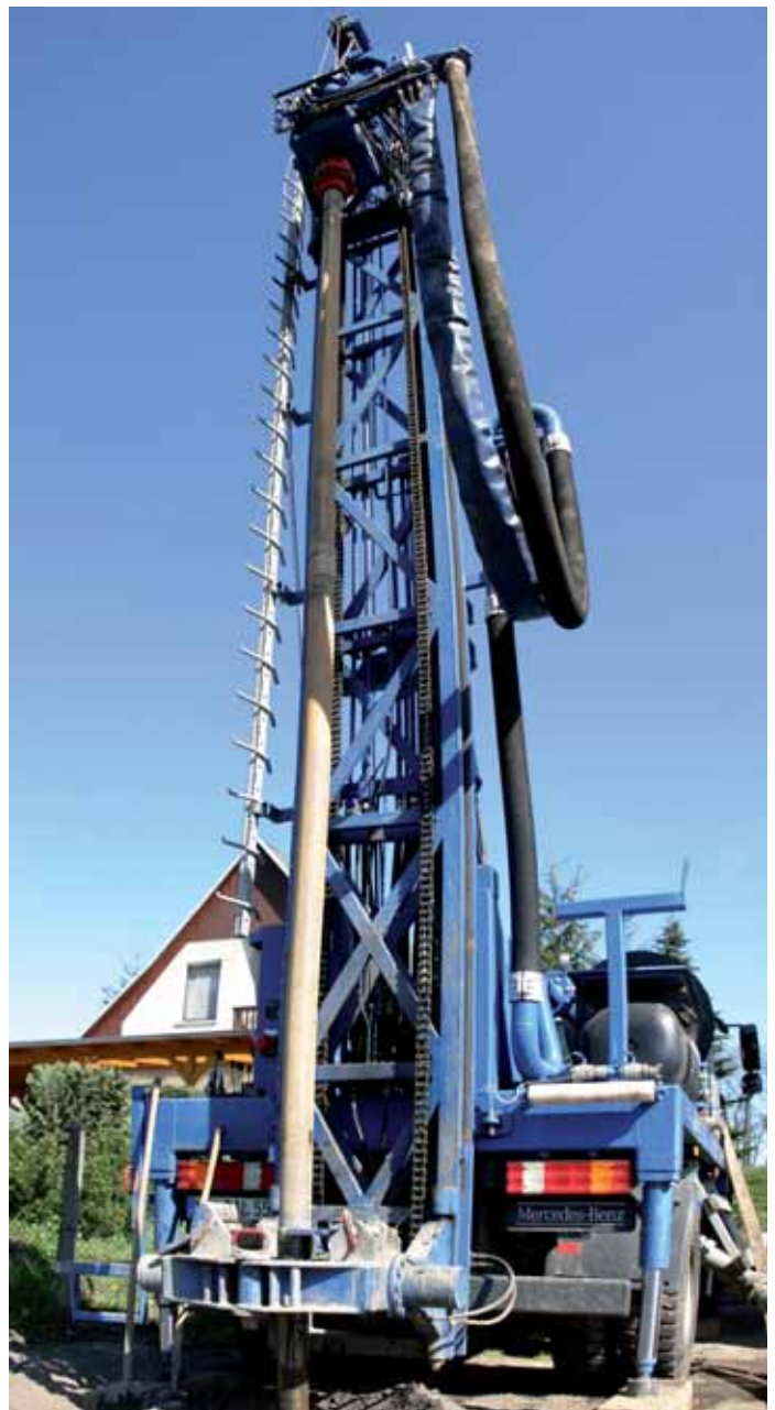
Jede Bohrung muss dem Landesamt für Bergbau, Geologie und Rohstoffe 2 Wochen vor Beginn angezeigt werden
