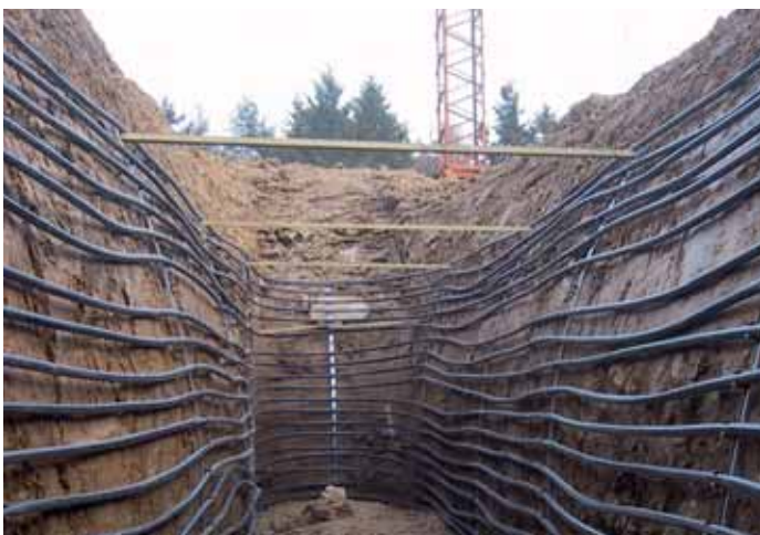
Einbau eines Grabenkollektors als flächensparende Variante
